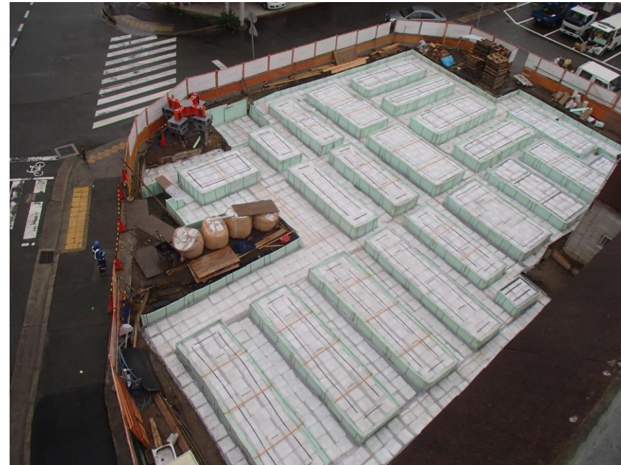
T-BAGS敷設工事完了
