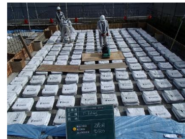
凍上防止でのT-BAGS施工例 (施工手順)
